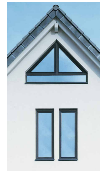
Pravoúhlá, vysoká okna bez dělicích příček optimalizují vstup světla.
