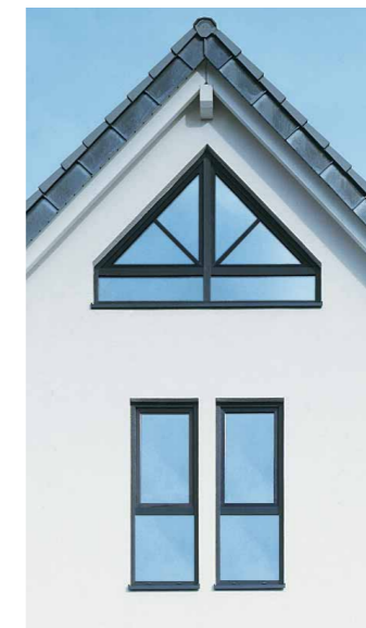
Vodorovně umístěné dělicí příčky podporují horizontály a opticky zvětšují šířku.
